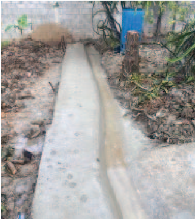
Mamá Tingo 1ra etapa, Vista al Valle
