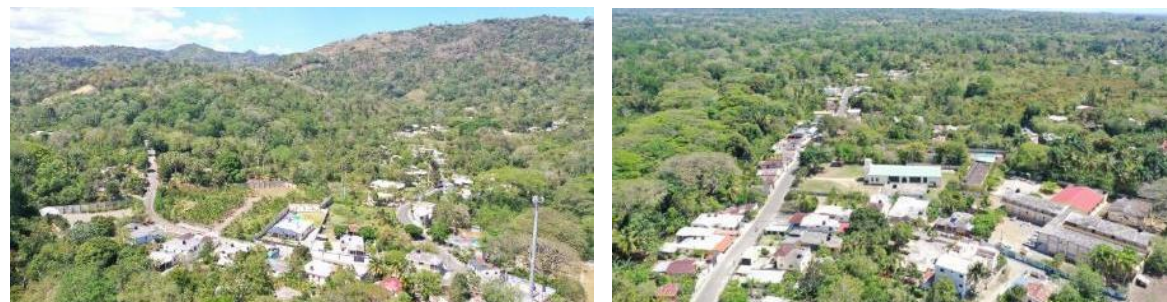
Fuente: Archivo propio, foto tomada con dron en visitas de campo – Jaya. IDOM, 2023
