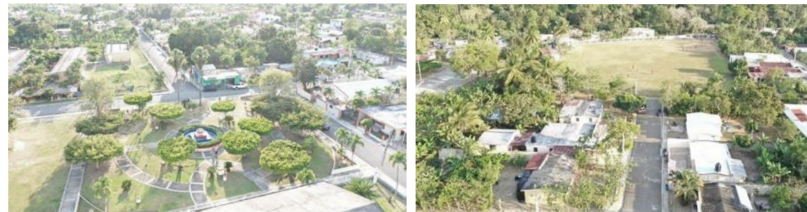
Plazoleta Parque La Peña – Play de Pelota – Carretera Pontón
